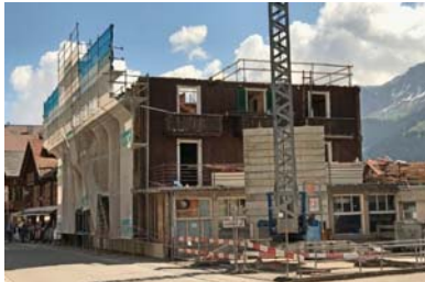
Die alte Alpenrose wird diesen Monat kontinuierlich abgerissen. Bild: Corina Kobi
