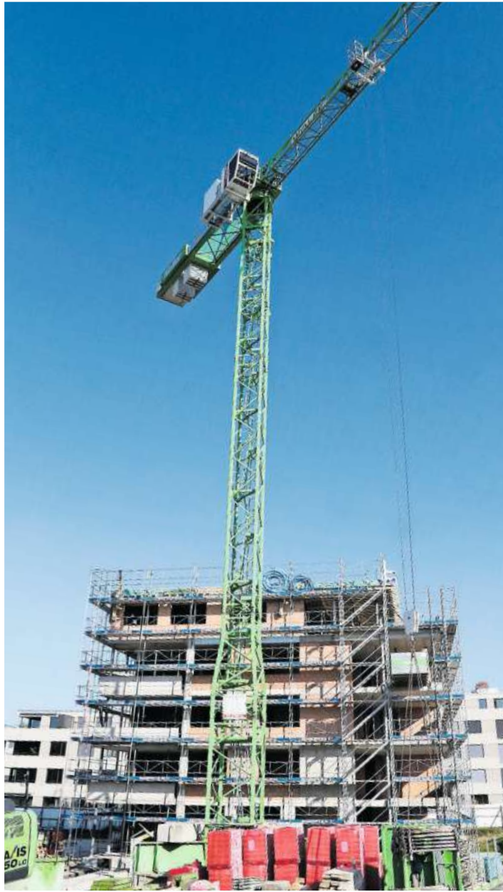
Ein eingerüsteter Rohbau der Siedlung Reutiwiesen. Dahinter die fertig, bereits bezogenen Häuser. Bild: Martin Rechsteiner
