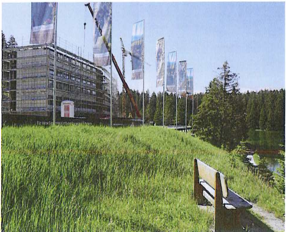
Die besondere Hotelbaustelle befindet sich in unmittelbarer Nähe des Heidsees auf der Lenzerheide.
