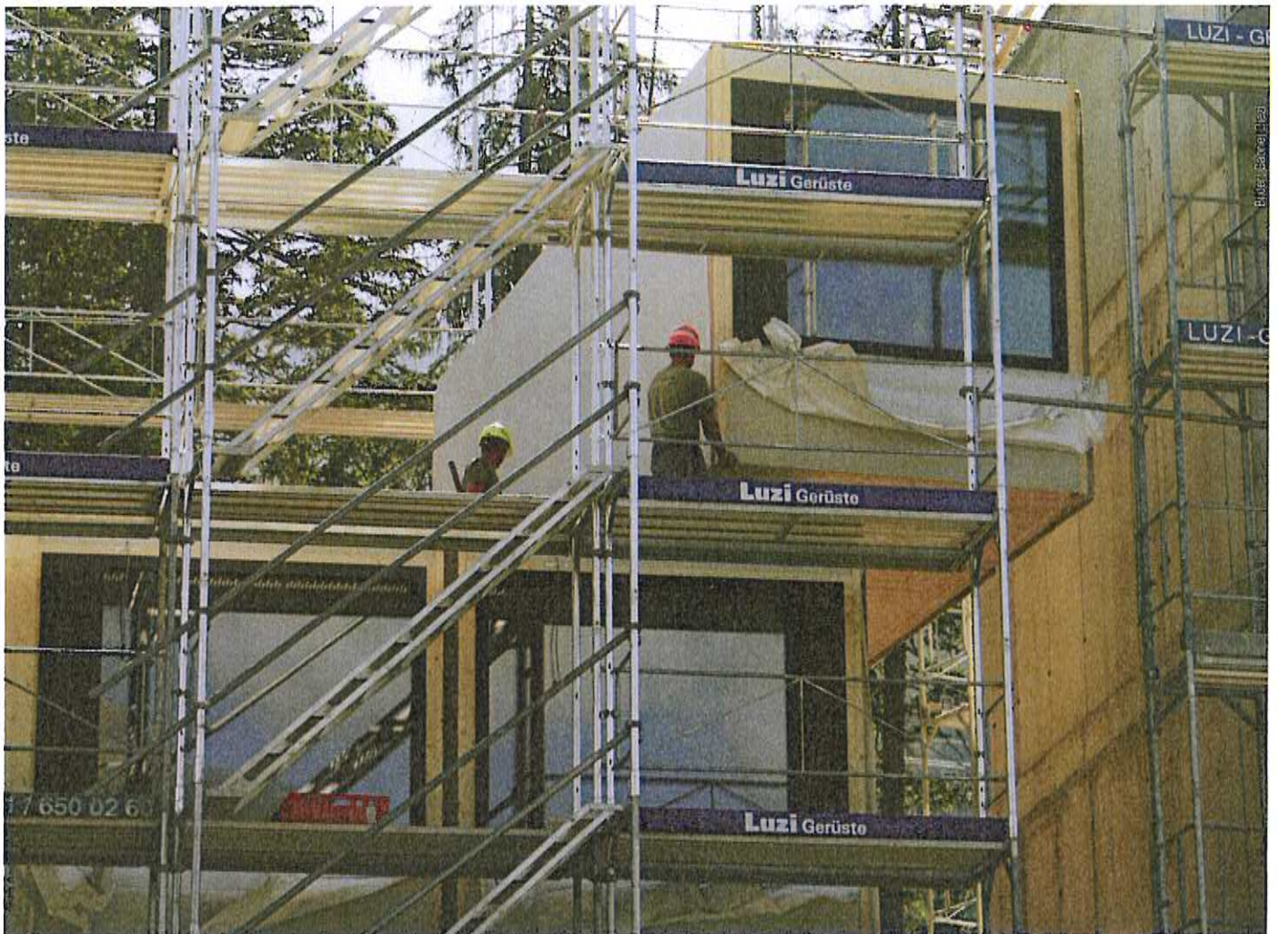
Ist das Zimmermodul per Pneukran an seinem angestammten Platz angekommen, wird es von Bauarbeitern in die richtige Position gebracht (oben) und anschliessend in die Lücke abgesenkt (unten links). Kurz darauf hievt der Kranführer bereits das nächste Doppelzimmer auf den Modulstapel (unten rechts).
