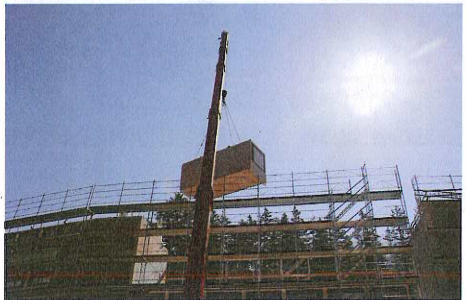
Ist das Zimmermodul per Pneukran an seinem angestammten Platz angekommen, wird es von Bauarbeitern in die richtige Position gebracht (oben) und anschliessend in die Lücke abgesenkt (unten links). Kurz darauf hievt der Kranführer bereits das nächste Doppelzimmer auf den Modulstapel (unten rechts).
