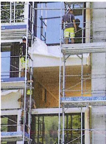
Ist das Zimmermodul per Pneukran an seinem angestammten Platz angekommen, wird es von Bauarbeitern in die richtige Position gebracht (oben) und anschliessend in die Lücke abgesenkt (unten links). Kurz darauf hievt der Kranführer bereits das nächste Doppelzimmer auf den Modulstapel (unten rechts).
